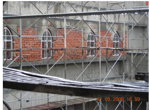
5/29 起鋁窗開始安裝工程。
