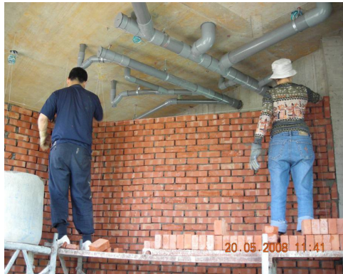
5/20 廁所磚牆與管路安裝完成。
